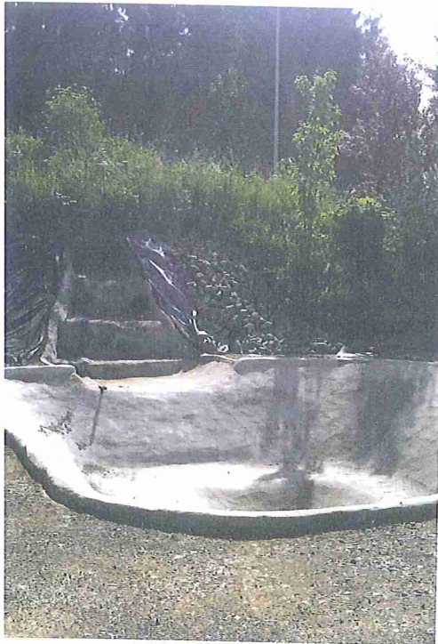
1 Teichbau mit Glasfaser- verstärktem Kunststoff (GFK).
